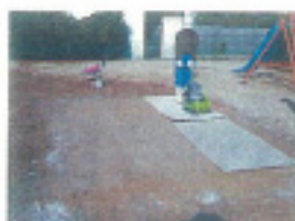
⑤ 転 圧・散 水
