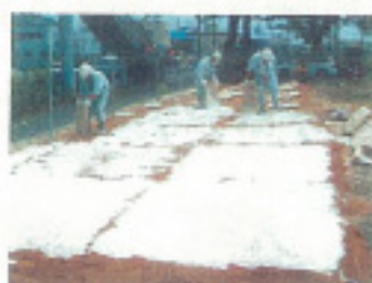
②【敷き均し】
