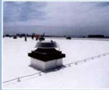
コンクリート屋根
