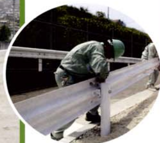
▲打ち込みキャップ 万能キャップによりボックスビーム、ガードパイプ、ガードレール（A・B・Cタイプ）を打ち込み可能。
