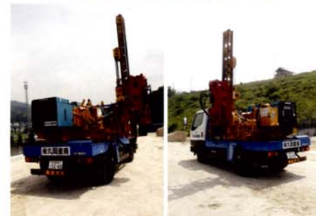
▲180度回転台座 状況に応じて左右両側で随意に施工。
